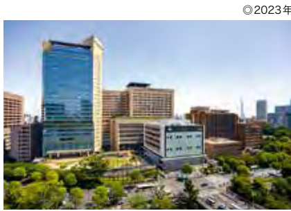
◎2023年 C棟完成 ERセンター、手術室、集中治療室（ICU）、医療器材、医療情報システムなど、病院の機能を強化するための施設として使われている。
